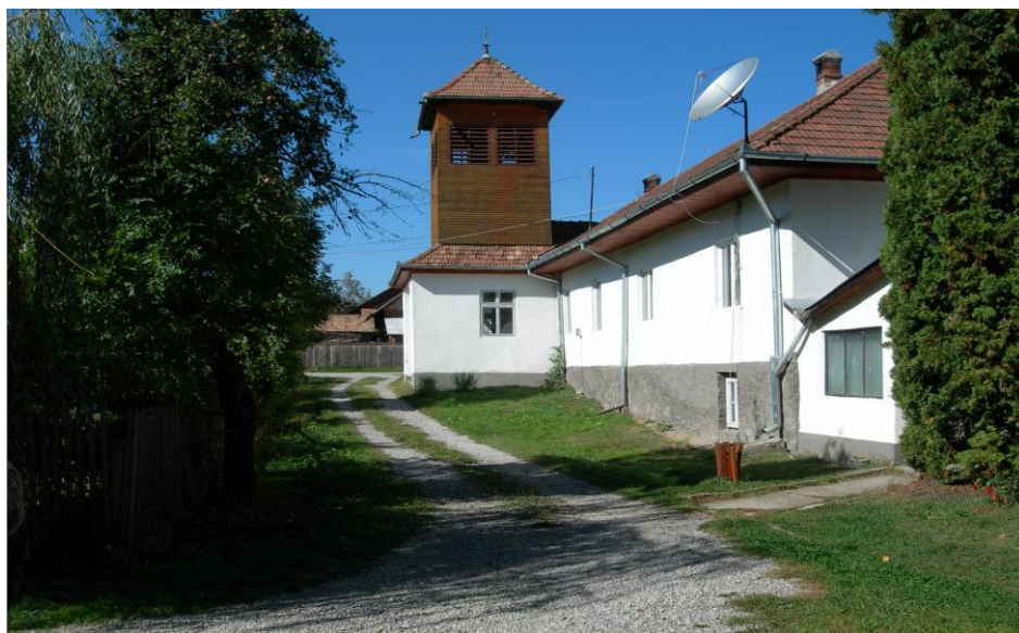
Kapelle mit Pfarrhaus – bereits mit neuer Fassade – wird zu einem Jugendzentrum
