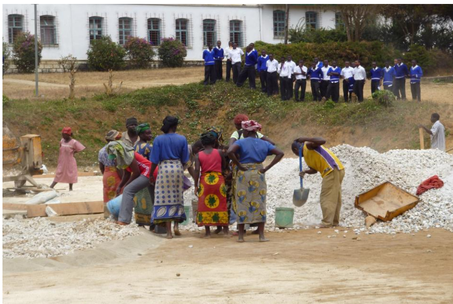
Der Bau des Basketballplatzes in Kasita hat für viele Menschen Arbeit und Einkommen generiert, weil alles in Handarbeit entstanden ist.
