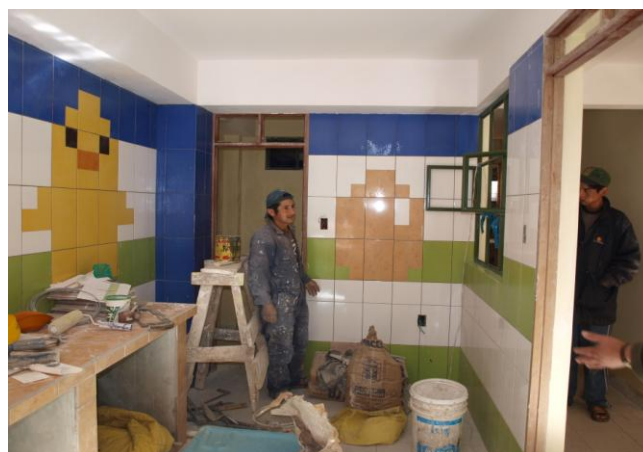
Die Küche ist am Entstehen
