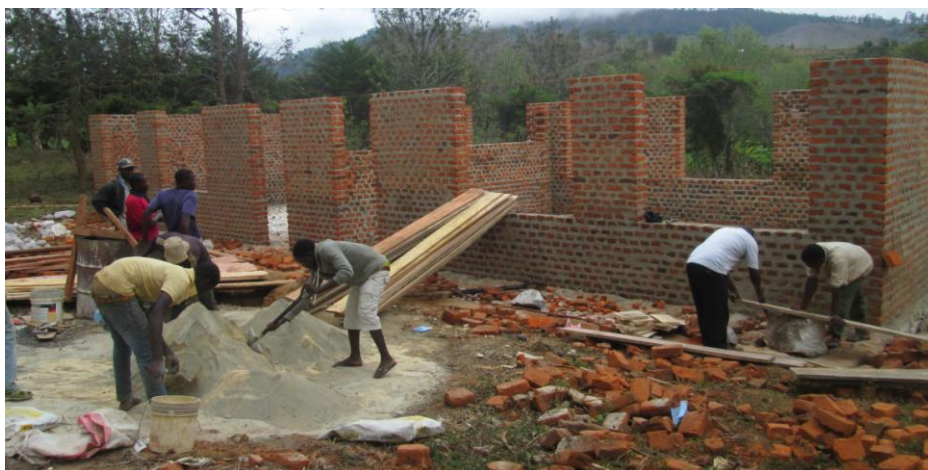
Die Bauarbeiten der Schulzimmer gehen zügig voran
