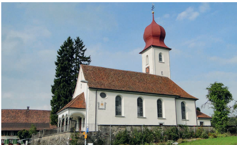
Die alte Pfarrkirche Oberschongau hat eine fast 1000-jährige Geschichte. Sie kann nur dank Kollekten und Spenden erhalten werden. Bild: Stiftung alte Pfarrkirche
