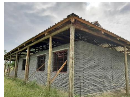
Gebäude am Entstehen
