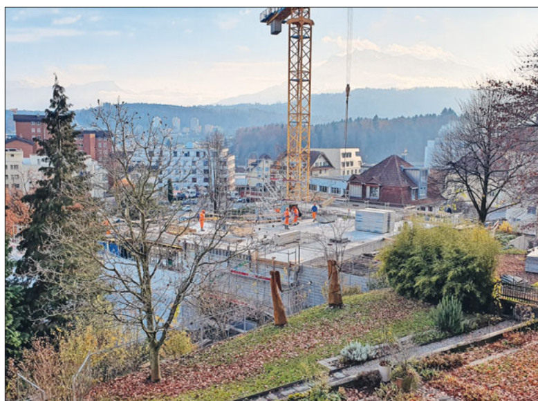
Baustelle Pfarreizentrum Gerliswil. Foto: W. Amstad
