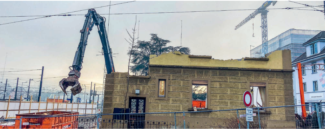
Hausabbruch am Seetalplatz in Emmen.
