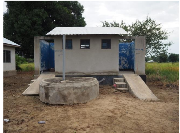
Bau einer WC-Anlage in der Schule
